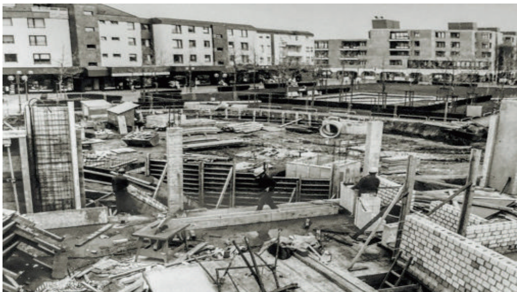
Das Fundament der katholischen Kirche; General-Anzeiger, Foto: Heinz Engels - 24.3.1992
