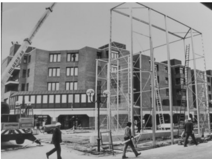
Der Bau des „Grünen Hauses“ genannt „Affenkäfig“ Foto: Heinz Engels, General- Anzeiger 24.04.1985
